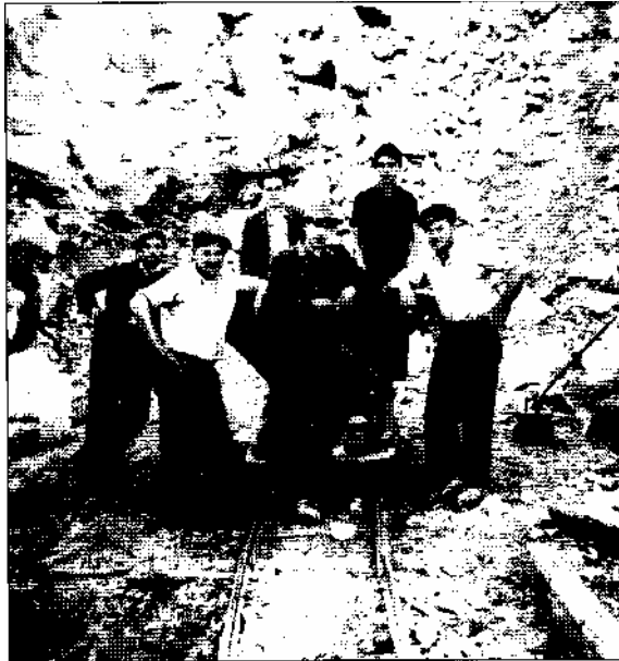
Abb. 7: Josef Göbel, Hermann Hudetschek, Alfred (?) Blauensteiner oder Steyrer, Rudolf Hirsch, Franz Waigl und Franz Fraberger (von links nach rechts) mit einem der Eisenhunte. Die Schienen mußten bei jeder größeren Sprengung abgebaut und danach neu verlegt werden. Das am Boden stehende Gefäß rechts ist ein wassergefülltes Holzschaff mit langgestieltem Trinkschöpfer, das für die durstigen Steinbrucharbeiter stets bereitstand.
