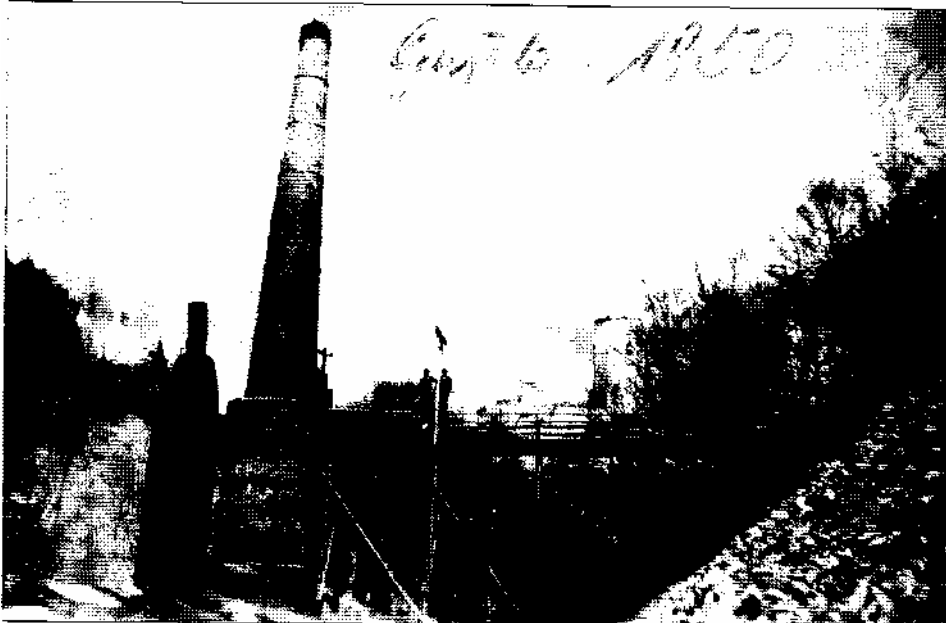
Abb. 8: Aufnahme aus dem Jahr 1950 von Johann Schrimpf, Brunn/Wild: Links der alte Eisenofen, daneben der obere Teil des gemauerten Schachtofens mit der Schienenbrücke, auf der die Hunte durch eine Eisentüre direkt in den Ofen fahren konnten. Am linken unteren Bildrand ist gerade noch der Giebel der Werkshalle zu sehen, aus der die beiden Öfen herausragen.
