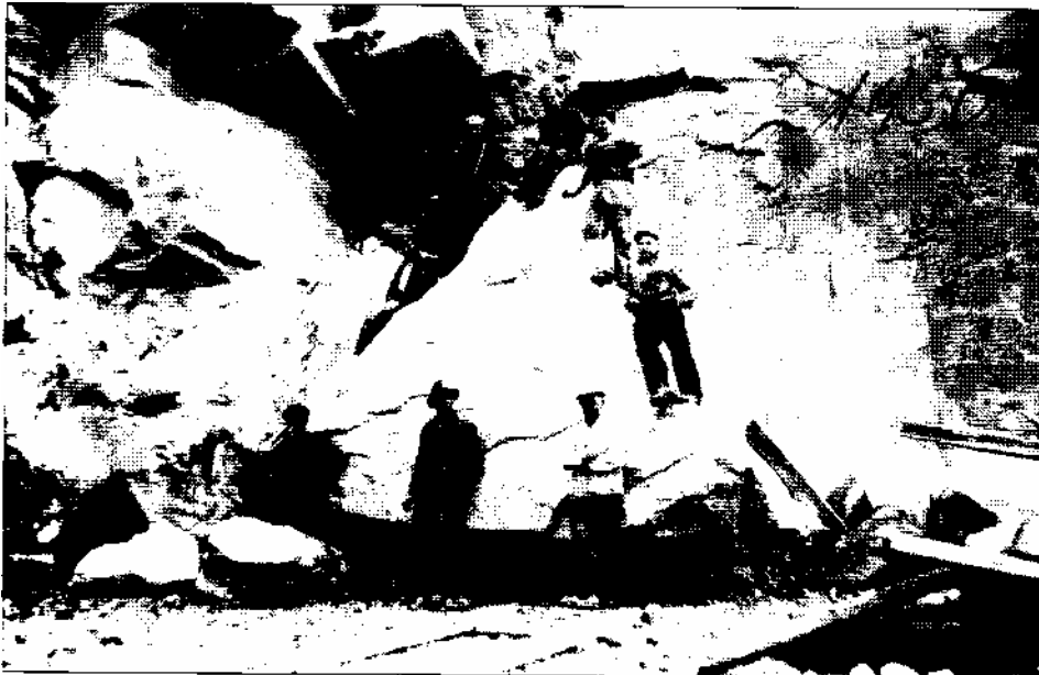
Abb. 6: Abgesprengter Block vor der Abbauwand, der durch weitere Sprengungen zerkleinert werden mußte. Arbeiter vor dem Stein, von links nach rechts: „ein Ausländer“ (wahrscheinlich Ungar) aus Dietmannsdorf/Wild, Gottfried Hauer, Johann Schindler; Arbeiter auf dem Stein, von links nach rechts: bisher unbekannte Person, Franz Fraberger, Richard Kastner, Leopold Futterknecht und Karl Kainz.
